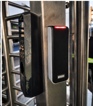
INSTALACIÓN DE LECTORES Y BOTONES DE ACCESOS
