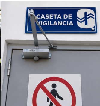
MONTAJE DE CIERRAPUERTAS HIDRÁULICOS
