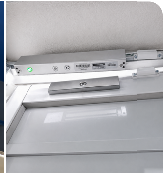
INSTALACIÓN DE CHAPAS ELECTROMAGNÉTICAS
